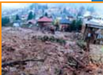
A Varallo durante l'evento del novembre 1994 una colata di fango distrugge due edifici e causa la morte di quattordici persone
