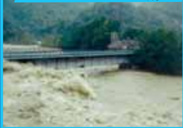
Ponte per loc. Isola, frazione di Vocca, durante l'evento del Settembre 1993
